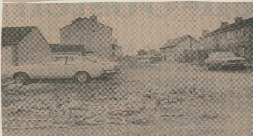
Alle straten in plan „Zeelst-Oost omgeving Blaarthemseweg”, met uitzondering van Biezenkuilen en Jikteind, kunnen
